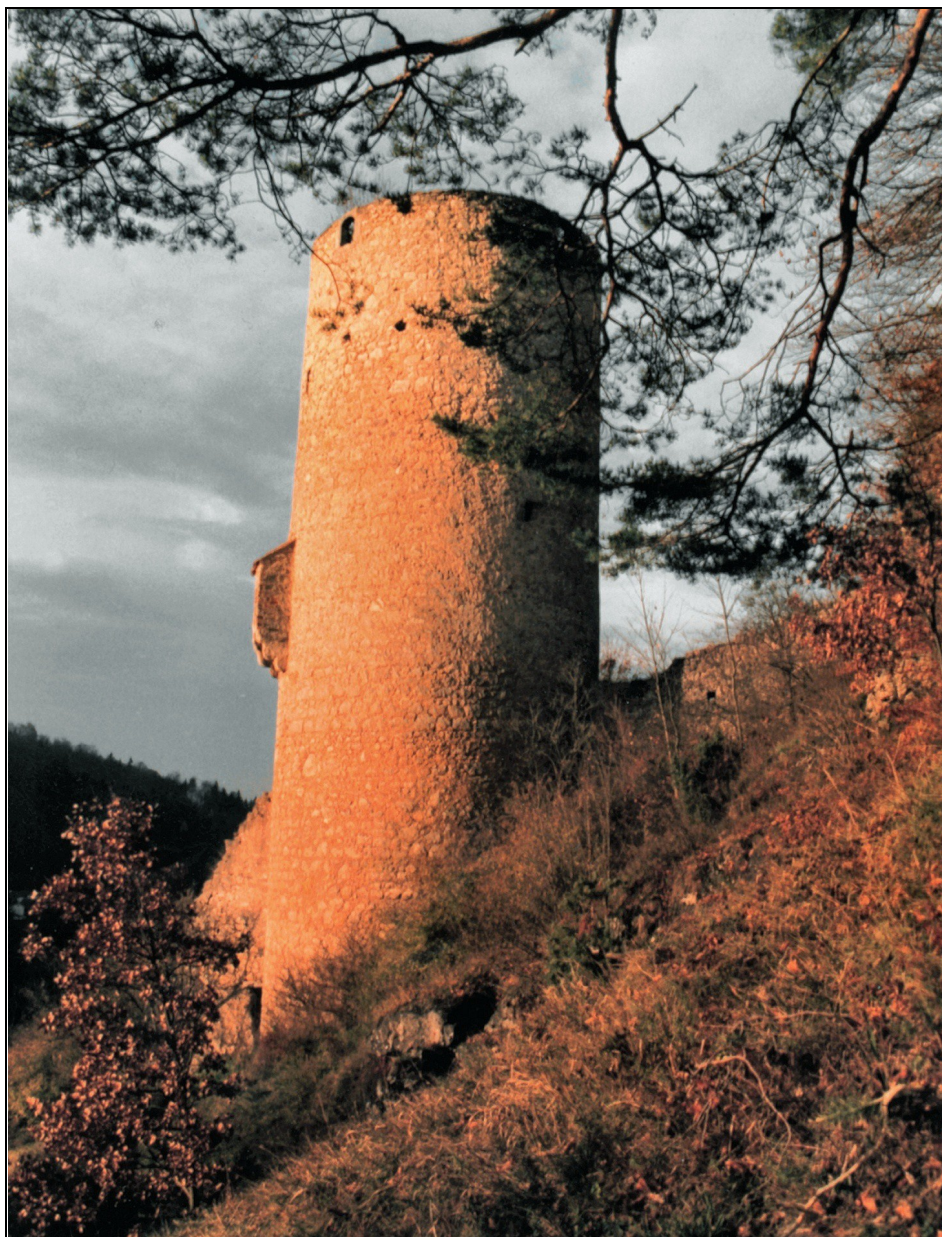
Der Bergfried der einstigen Höhlenburg Loch bei Eichhofen
